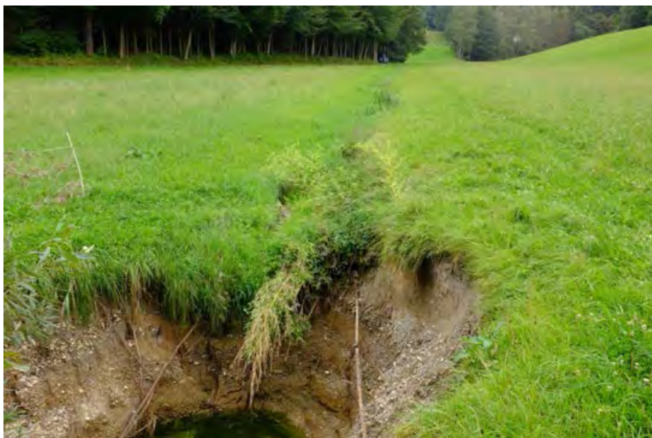
Abb. 59: Wenige Meter oberhalb der Abb. oben, Blick in entgegengesetzte Richtung auf das Bächlein, das zum Wildbach wurde. Der Talgrund war nach Aussage eines Anwohners zeitweise komplett überschwemmt.
