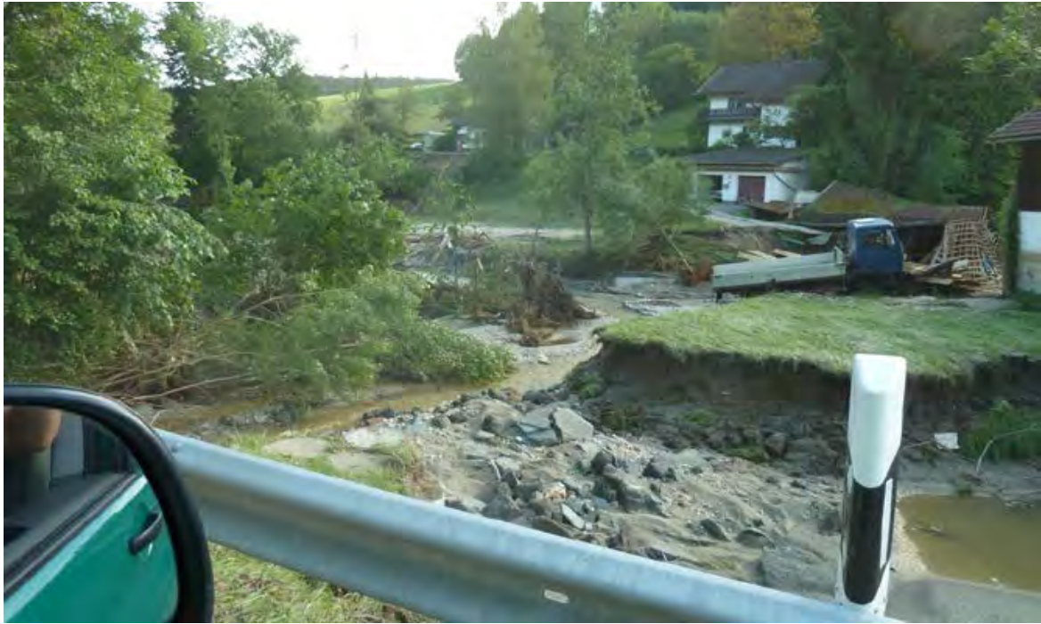
Abb. 64: Massive Uferabrisse oberhalb Simbach, Foto 03.06.2016
